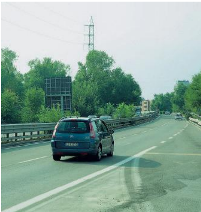
Tangenziale Sud In vista lavori di asfaltatura e restrizioni di corsie.
